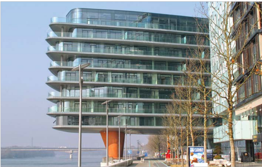
River house - Bratislava, Prodis plus s.r.o. (SK)
